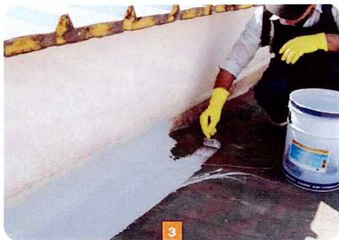
Styki z ścianą , kominy, okapy i ogniomurki nanieść membranę poliuretanową
