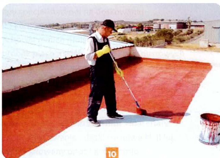
Nałóż trzecią warstwę membrany poliuretanowej z barwnikiem
