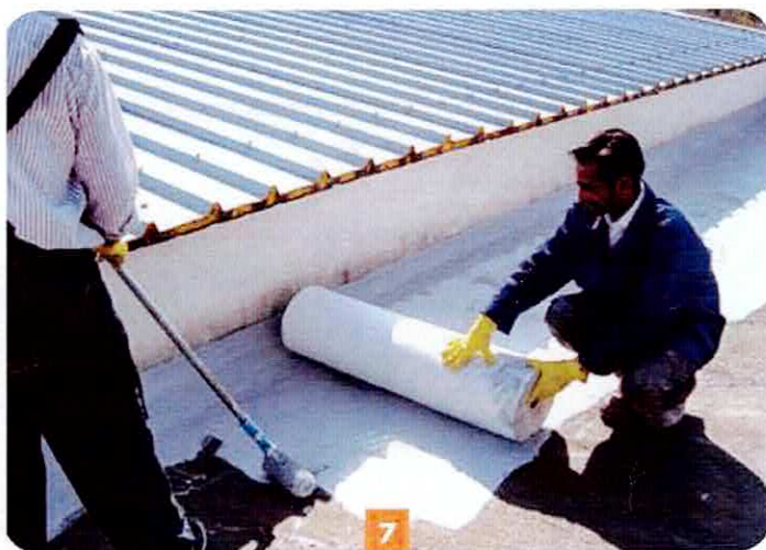
Nanieść tkaninę techniczną o szer 100cm z zakładami 5-10 cm
