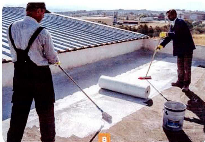
Wtop tkaninę techniczną w pierwszą warstwę membrany poliuretanowej ( wg instrukcji preparatu)
