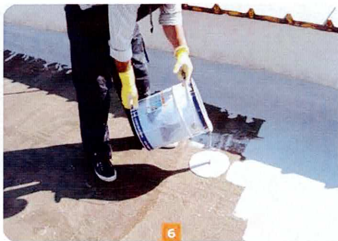
Nanieść pierwszą warstwę membrany poliuretanowej
